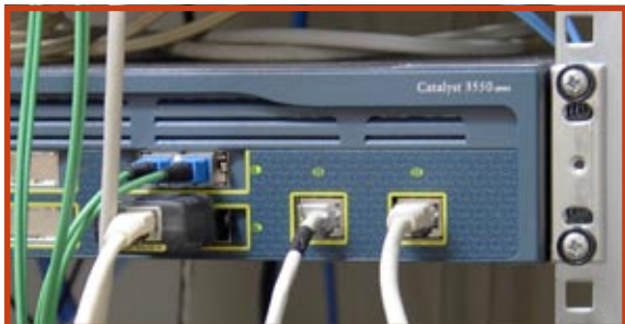
Jeden z centrálních switchů CISCO 3550
